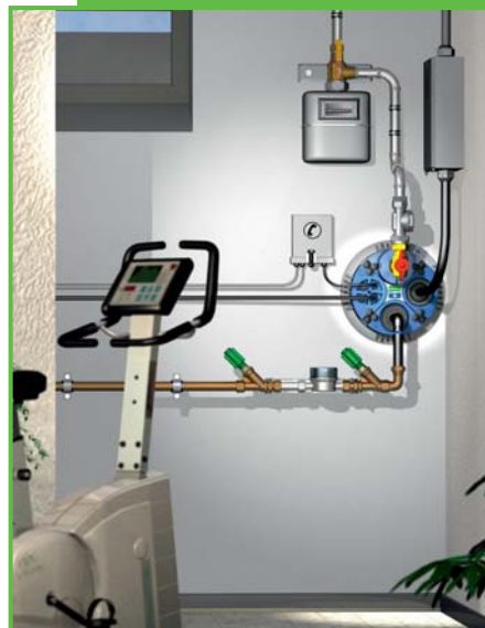
Bild 3: Mauerdurchführung mit Hilfe einer Mehrspartenhauseinführung
